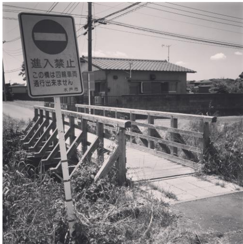
遺構：ガーダー橋
