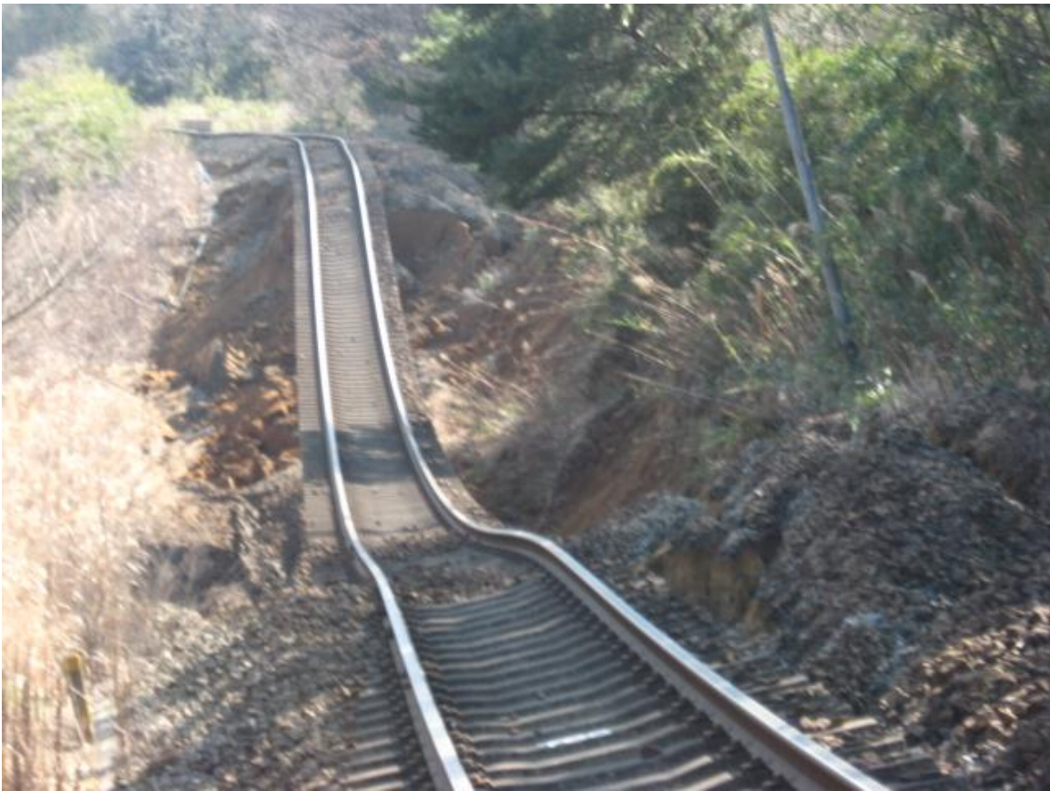
大洗鹿島線 北浦湖畔駅・大洋駅間 路盤崩壊
